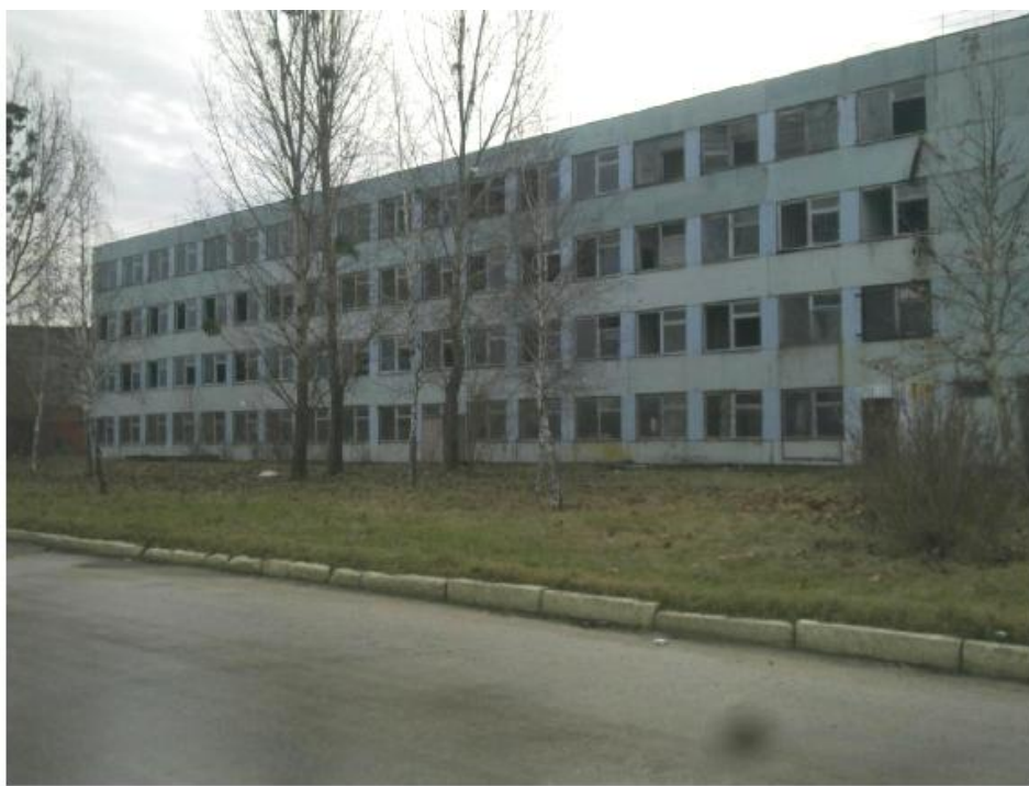
Foto 8. Bloc administrativ (fațada)
