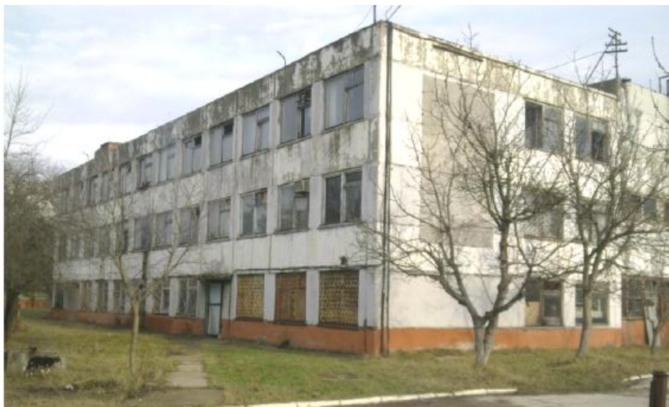
Foto 7. Blocul 3 (privire din partea blocului sanitar )
