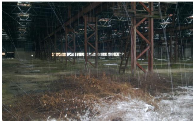
Foto 2. Hala principală de producere (Blocul II. Nefinisat).
